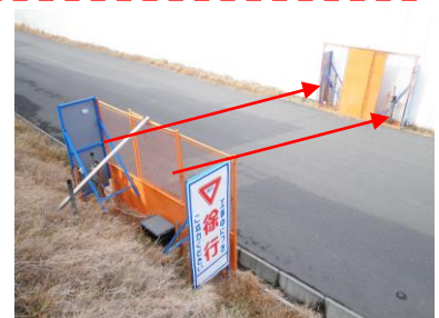
センサーを正対するように設置します。
