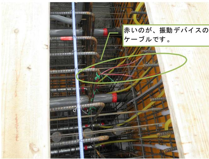
①振動デバイスを設置します。(今回は3箇所測定)
