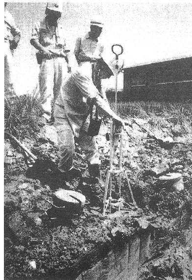
写真一２ No. 2 測点
