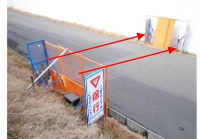
センサーを正対するように設置します。
