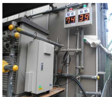
←収納BOX内部
